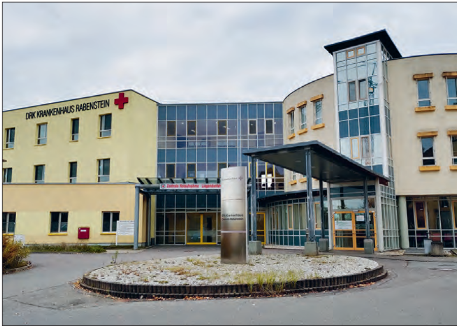
Eingangsbereich und Notaufnahme
